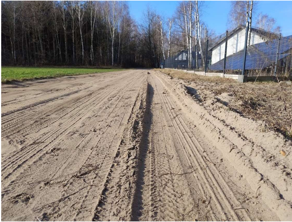
Załącznik nr 2 – zdjęcia wskazanej drogi
